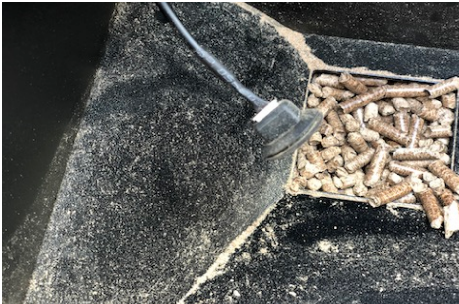
gummiprop med stik til pelletsensor
